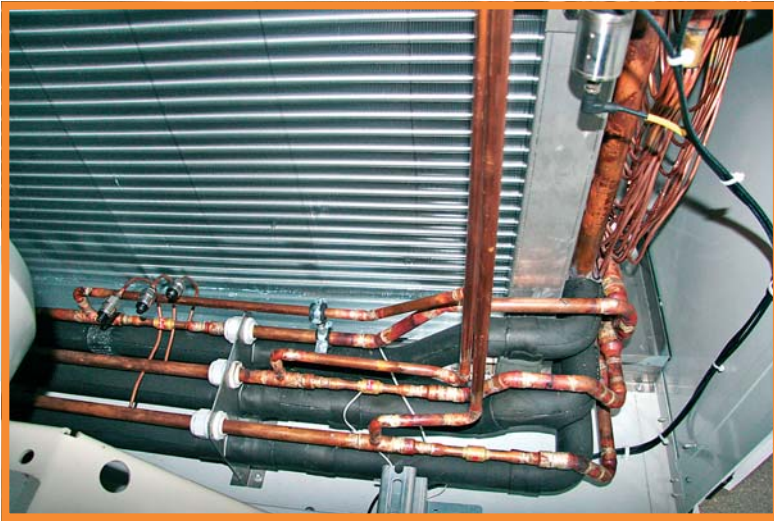
Isparivač Evaporator Испаритель
